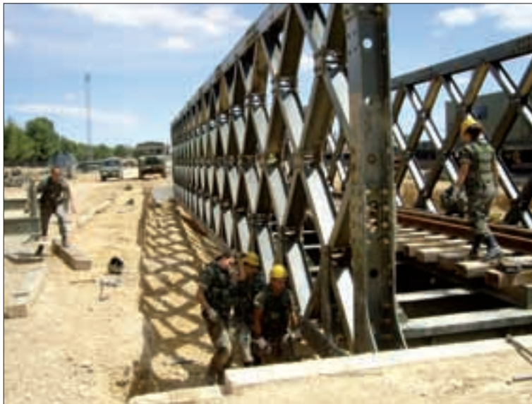
Una de las prácticas realizadas fue el montaje y desmontaje del puente MAN
