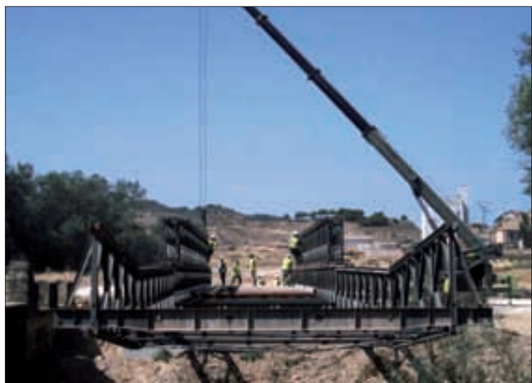
El puente tipo Bailey ha sido instalado a la derecha del existente
