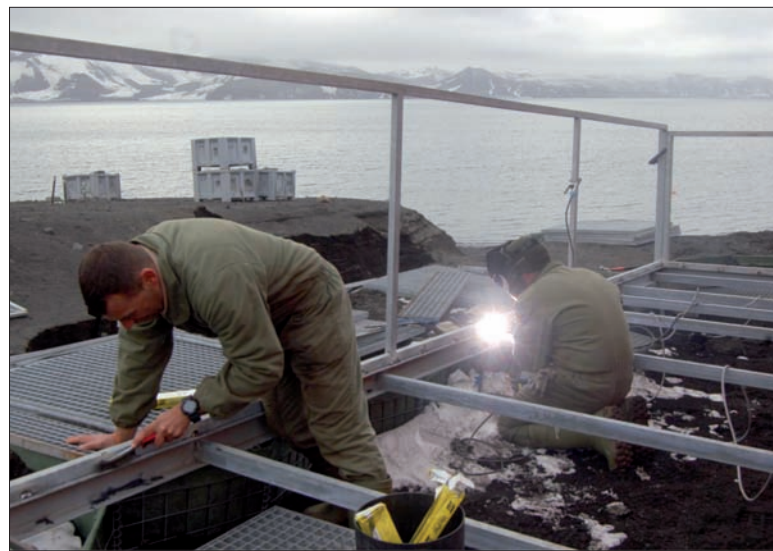
Trabajos para la mejora de las condiciones de vida en la base
