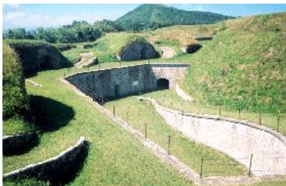
Patio de la obra de la Derecha. Túnel al patio de la batería de la obra del Centro. A su dcha. la rampa al terraplén de comunicación del que parten pequeñas rampas a los asentamientos de cañones, situados entre grandes traveses.
