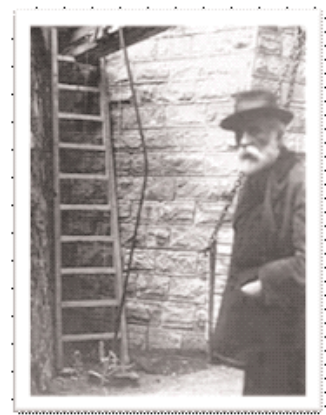
Gaudí en las obras de la Sagrada Familia, junto a una prueba de flexión de materiales.
