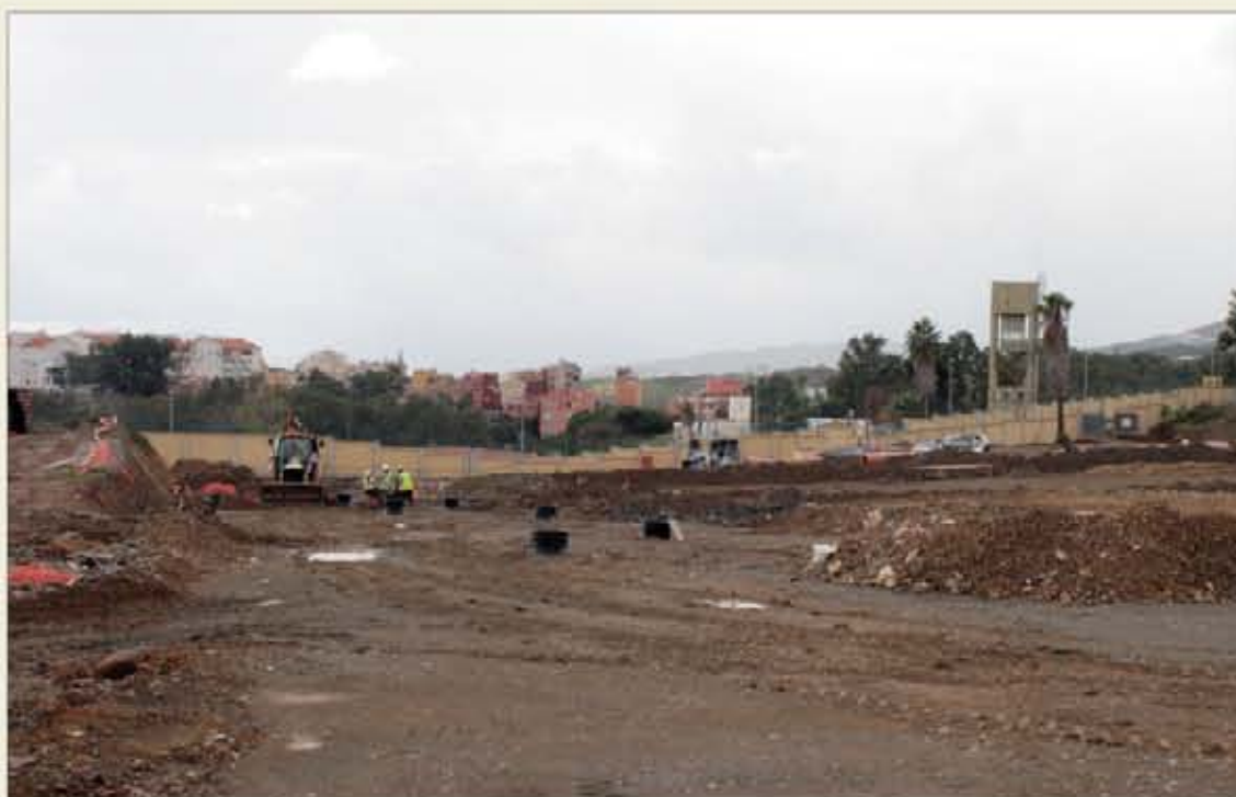
Vista de las obras de urbanización de la base ceutí, con el vallado perimetral al fondo
