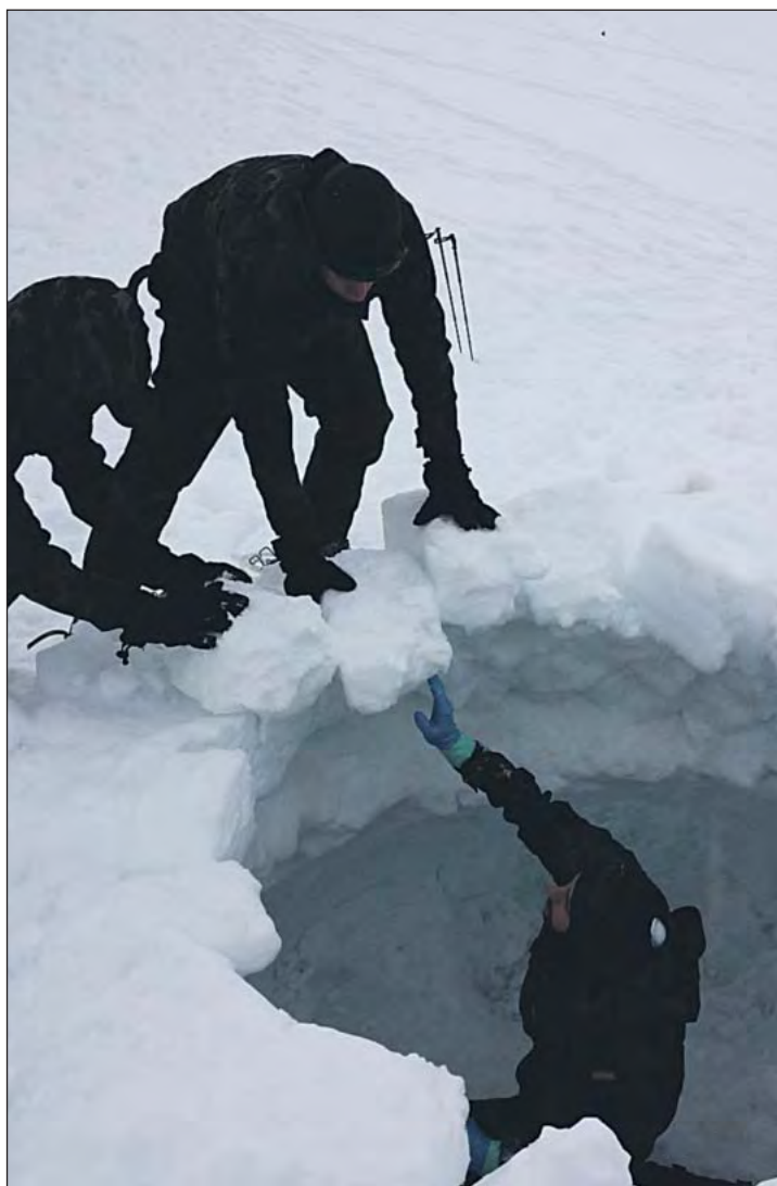
Un momento de la construcción de los iglús.
