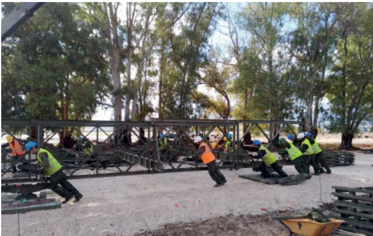
El puente lo forman piezas que se ensamblan y lanzan sobre unos rodillos hasta la orilla opuesta
