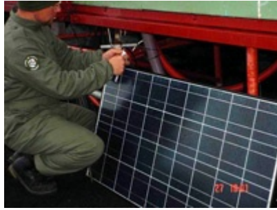
Realizando pruebas en paneles solares
