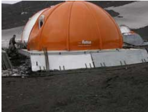
Protección de la plataforma contra el viento
