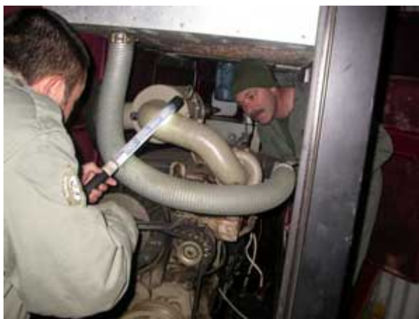
Mantenimiento de motores
