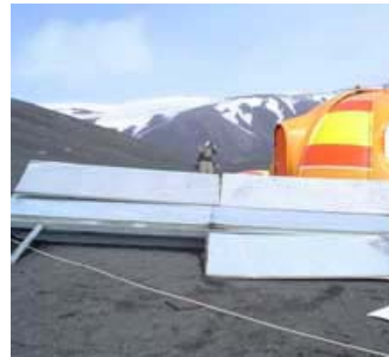
Daños por el fuerte viento
