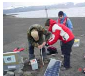
Instalación de panel solar en la Estación Sísmica Telemétrica
