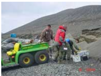
Retirada de baterías defectuosas
