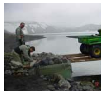
Trabajo en el puente
