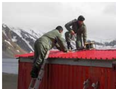
Reparando el techo
