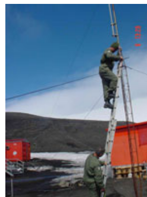
Instalación antena Módulo Científico
