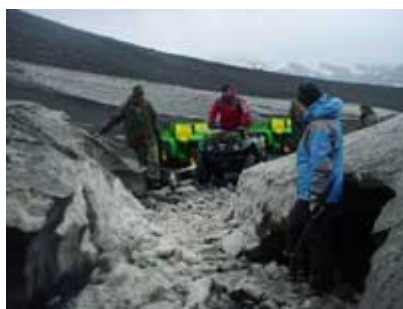
Paso habilitado para vehículos
