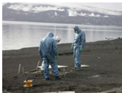
Limpieza fosas sépticas
