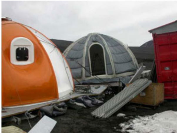
Colocación capa aislante iglú
