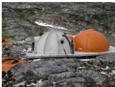
Desmontaje de los Iglúes
