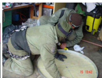
Reparando el iglú
