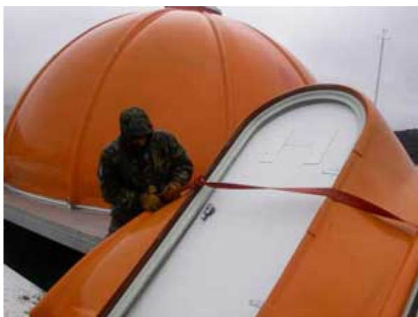
Protección del material contra el viento
