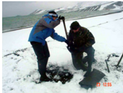
Mantenimiento en el proyecto TOMODEC
