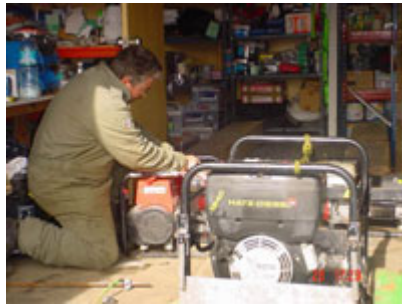
Puesta a punto grupos electrógenos
