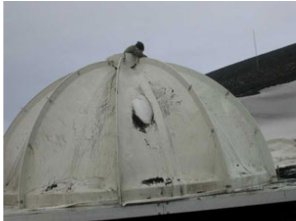
Montaje 1ª capa iglú
